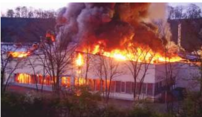
Am 14. April 2007 in den frühen Morgenstunden wurde die Feuerwehr Runkel zu einem Brand in einer Produktionshalle der Fa. Elring Klinger alarmiert. Bei Eintreffen der Feuerwehr befand sich die Halle bereits im Vollbrand. Die Löscharbeiten zogen sich bis in die Abendstunden. Es waren alle Stadtteilfeuerwehren von Runkel sowie die Feuerwehren aus Limburg und Villmar im Einsatz.
