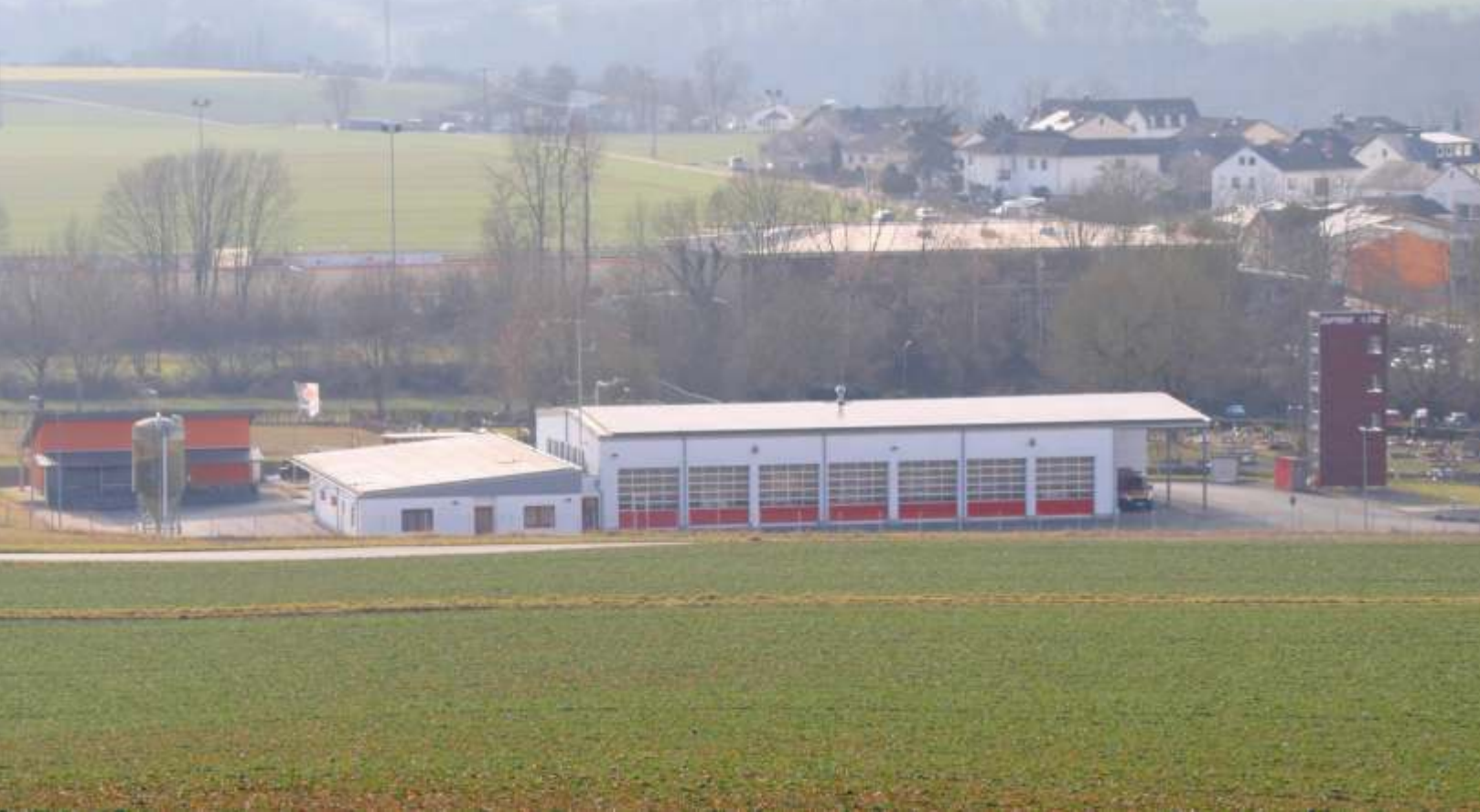
Seit 2012: Feuerwehrhaus der Feuerwehr Runkel+Schadeck
